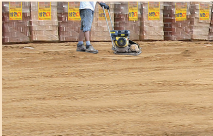
2. 살수 및 진동다짐 작업
